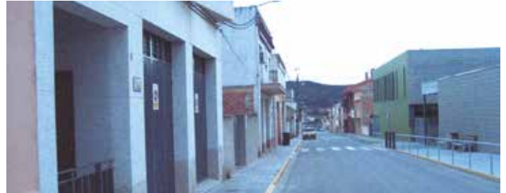
Les obres al carrer Wilson es preveuen fer aquest 2014
