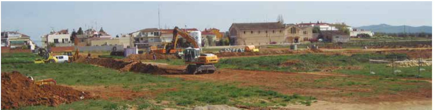
Amb la urbanització Moja també resoldrà deficiències en el clavegueram
