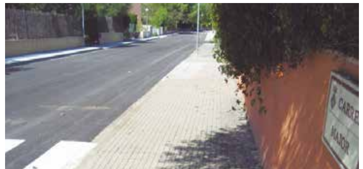
Acabar la urbanització del carrer era un compromís del govern municipal
