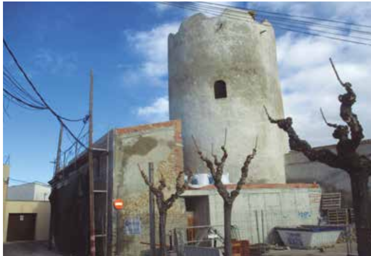
Ara es realitza l'adequació de l'edifici annex a la Torre
