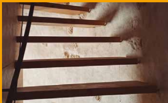
Es completa la restauració de la Torre de Moja | p. 5
