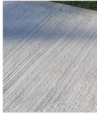
Paviment: formigó antilliscant
